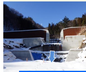
2号堰堤の前庭保護工事状況
