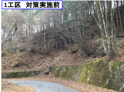
1工区 対策実施前
