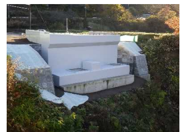
【浜岩橋右岸橋台の状況】
