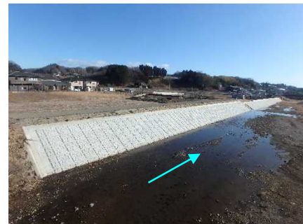
完成後の状況
