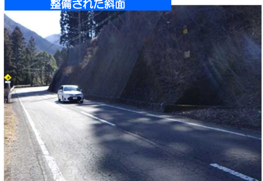
整備された斜面
