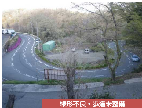
線形不良・歩道未整備
