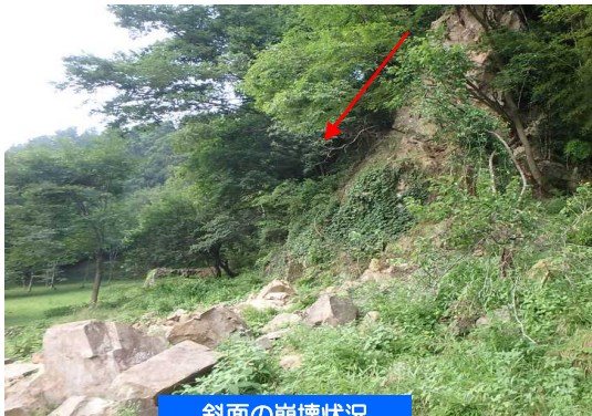
斜面の崩壊状況
