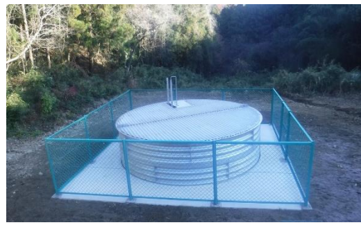
集水井A-1の完成状況 (R3.3)
