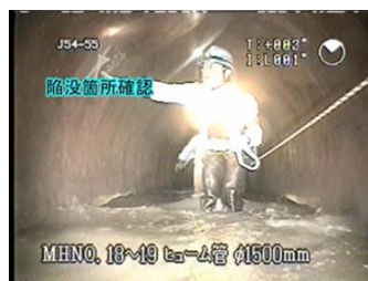
現場訓練イメージ(管路破損箇所調査)
